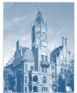
„Sanierung Kulturhaus Babelsberg“
